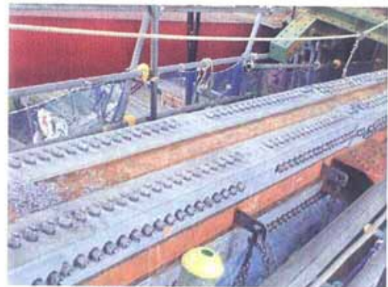
写真-11 鋼アーチ橋補強
