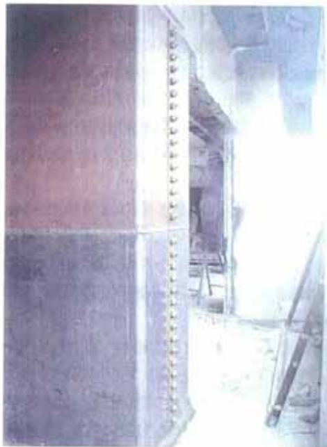
写真-10 RC柱鋼板巻き補強
