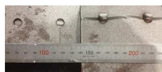
写真-1 V2-02 ねじ・鋼板破断
