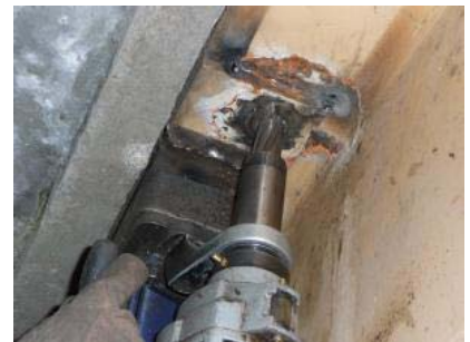
⑫アトラーによる掘削
