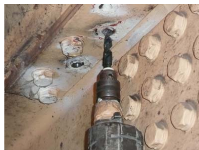
③鉄鋼ドリルによる下孔あけ
